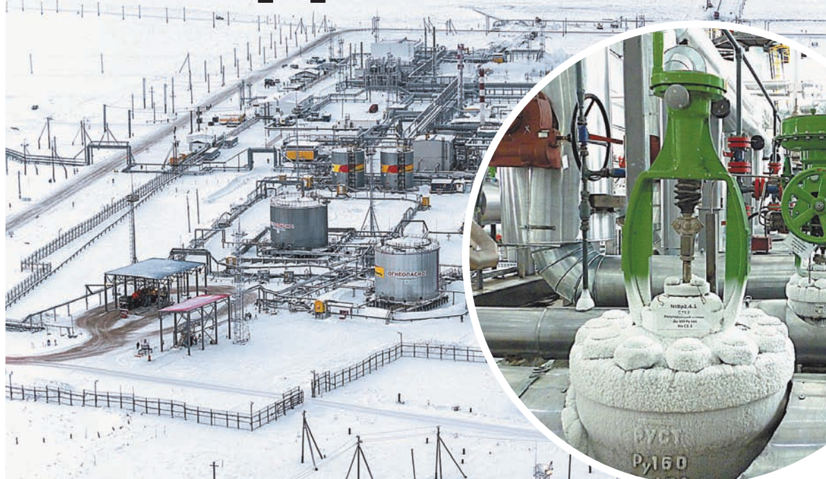
Установка комплексной подготовки газа и конденсата на Ново-Уренгойском лицензионном участке с октября прошлого года работает на полную мощность. Здесь газ отделяют от конденсата, резко снижая температуру. Поэтому на аппаратах и трубах цеха сепарации иней всегда - и зимой, и летом.
