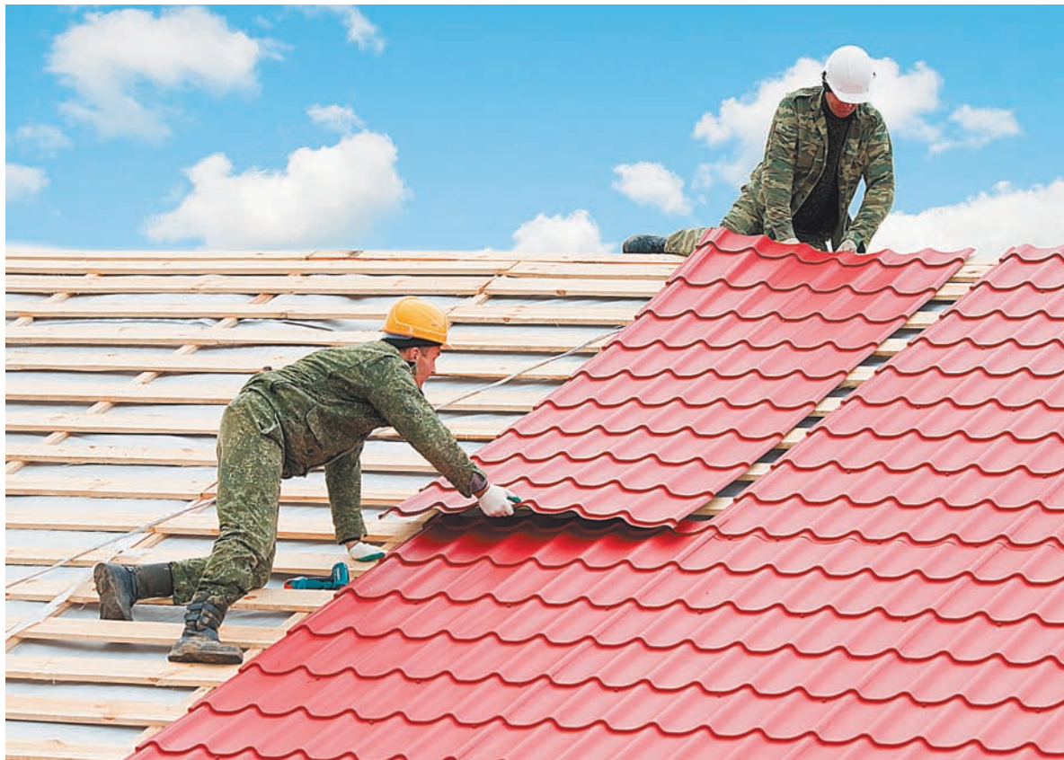
Высокая волна металлочерепицы хорошо держит тяжёлый снег зимой и не деформируется.
