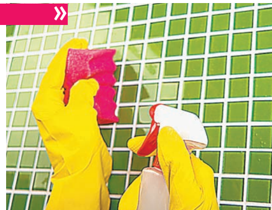
Зачистка - фунгицид - антисептик. И никакого грибка на стенах!
