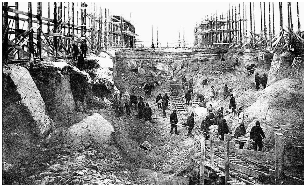
Строительство котлована для первого промышленного ядерного реактора «А1» на территории завода № 817 («Маяк»), осень 1946 г. Реактор был запущен 19 июня 1948 г. и проработал до 1987 г. За эти годы было получено 6,5 т плутония.
