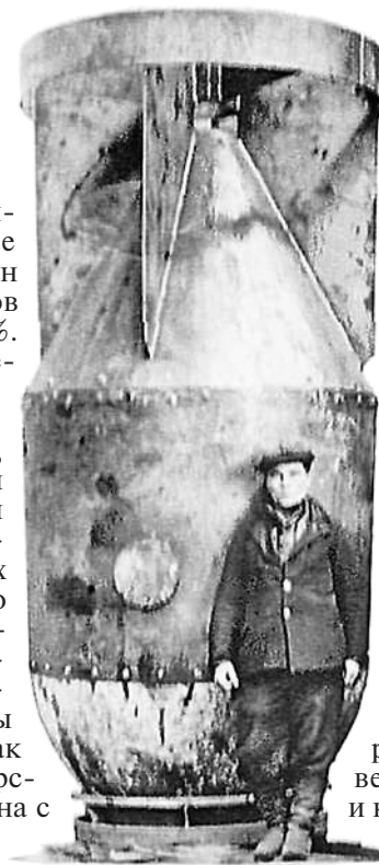
Прототип корпуса первой советской атомной бомбы.
