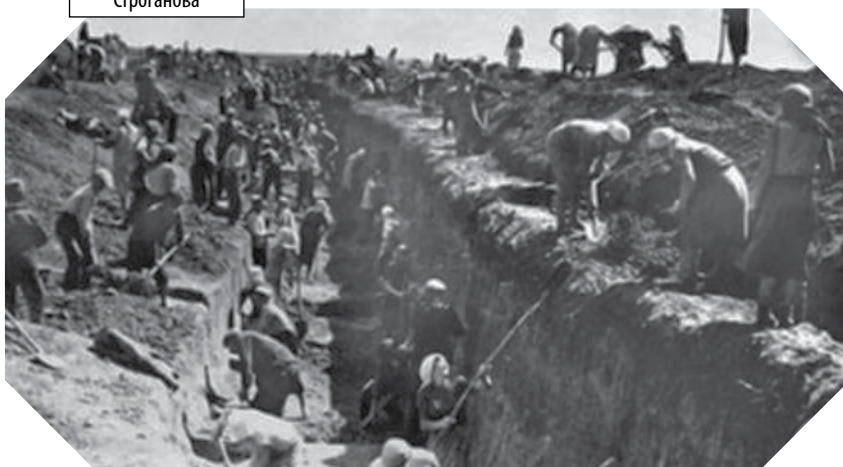
На строительстве оборонительных сооружений
