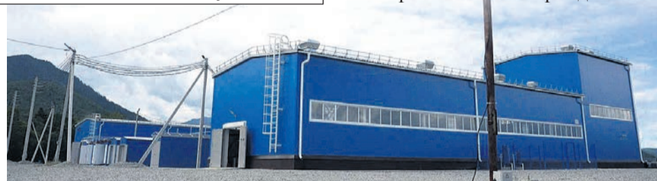
В Байкальске завершено строительство всех необходимых объектов для очистки опасных отходов бывшего БЦБК.
