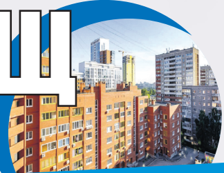
улица Щорса. В 2019 году часть улицы отремонтировали по программе «Безопасные и качественные дороги»
