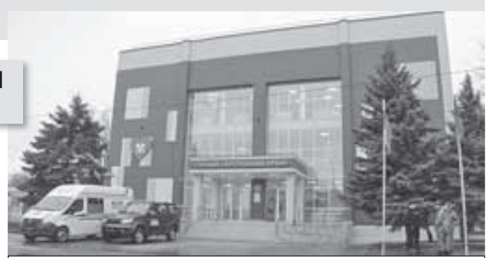
Строительство нового перинатального центра в Донецке.
