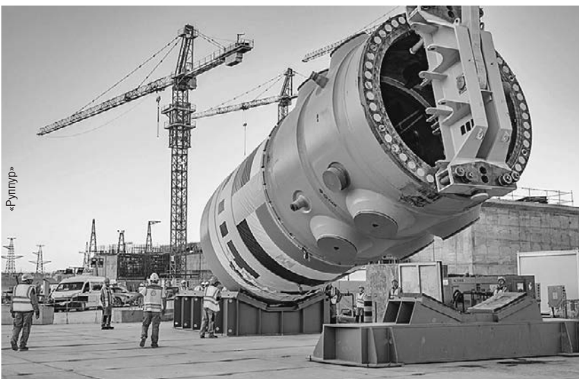
В Египте установили в проектное положение корпус реактора первого энергоблока АЭС «Эль-Дабаа».
