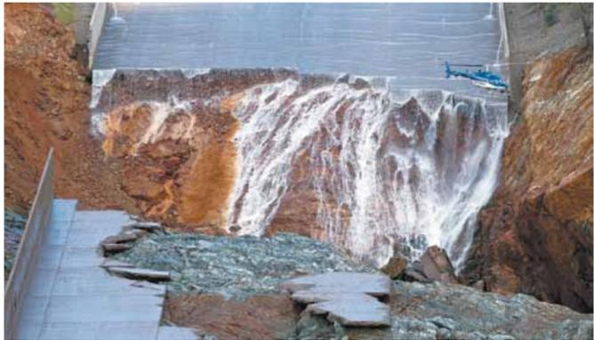
**Тан выглядит с вертолета поврежденный водослив Оровиллской плотины** (самая высокая в США — 235 метров в высоту) в Калифорнии. В начале февраля из-за сильных дождей на водохранилище был начат активный сброс воды. Из-за разрушения желоба водосбора возникла необходимость эвакуировать население. Но ситуацию в целом удалось нормализовать, власти прекратили сброс воды, а рабочие приступили к восстановительно-очистным работам.
