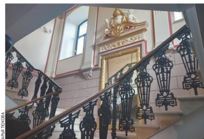
скрыты под несколькими слоями более поздней краски. «Один из самых интересных сюрпризов ждал нас при реставрации лестницы. Мы обнаружили, что в ее основе — чугунный железнодорожный рельс, привезенный из Англии. На нем есть соответствующее клеймо. Его использовали в качестве каркаса, а уже сверху закрепили каменные ступени», — рассказал главный инженер проекта Андрей Филиппов
