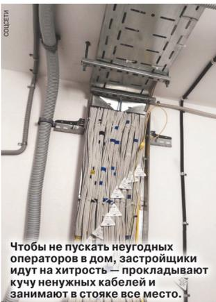
Чтобы не пускать неугодных операторов в дом, застройщики идут на хитрость — закрывают кучу ненужных кабелей и занимают в стойке все место.
