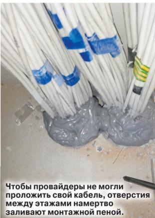
Чтобы провайдеры не могли проложить свой кабель, отверстия между этажами намертво заливают монтажной пеной.
