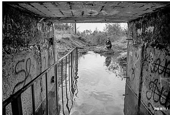
— Этот объект — не подземный переход, а техническое сооружение — водопропускная труба. Она действует в соответствии со своими прямыми функциями — пропускает поток воды в городской коллектор. Она предназначена для пропуска воды, чтобы насыпать не размыва-
