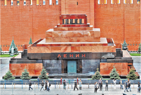
После ремонта фундамента в 2013 году может стоять вечно.
