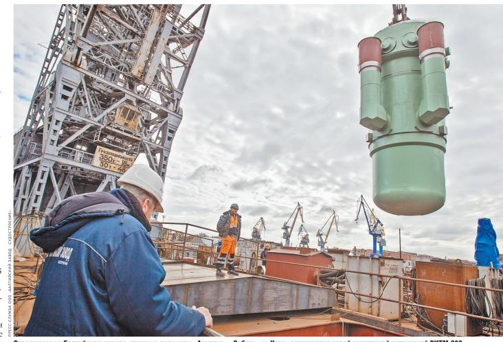
Строящиеся на Балтийском заводе атомные ледоколы «Арктика», «Сибирь» и «Урал» оснащаются новой реакторной установкой РИТМ-200.
