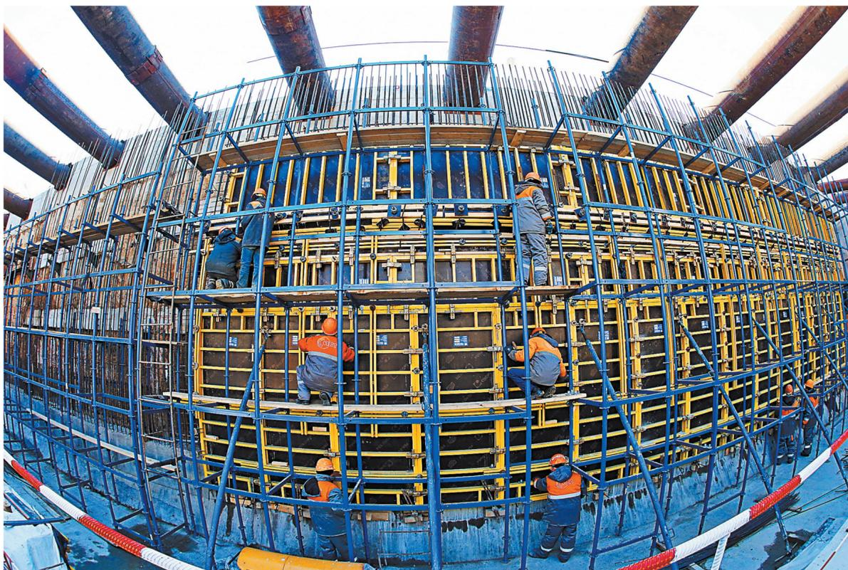
Котлован сейчас разбит на две части: в одном экскаваторы продолжают работать с грунтом, в другом сооружаются арматурные конструкции — будущие колонны станции.
